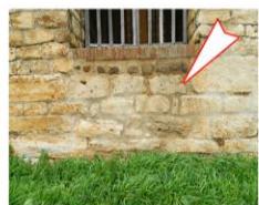
Lo sfasciamento della base del campanile, a destra, dimostra che è stato davvero realizzato sopra una struttura preesistente. Sopra la porta murata
